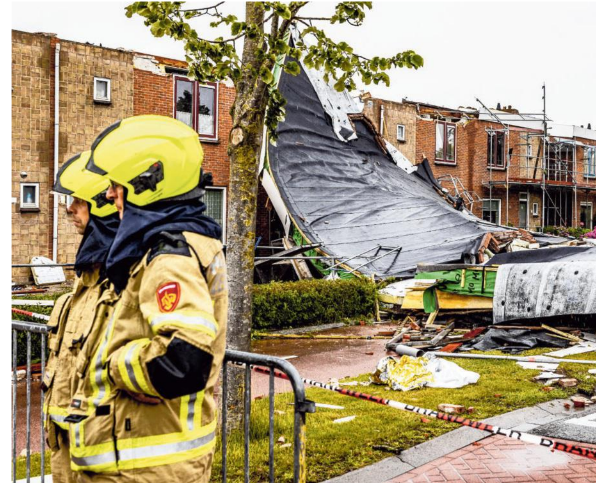
Een windhoos in Zeeland veroorzaakte afgelopen juni forse schade aan woningen .
